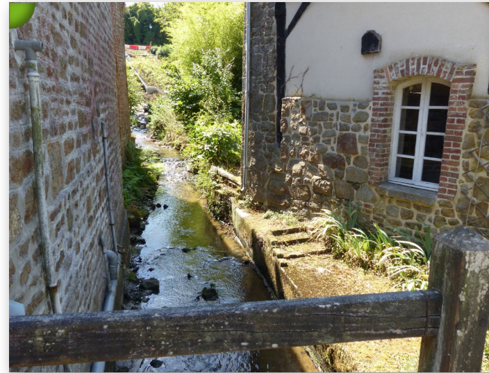
Ancien moulin le long de la Gine : soubassement et chaînage d'angle en moellons de granit ocre-brun, encadrement en brique, pans de bois et enduit clair, à la Carneille.
