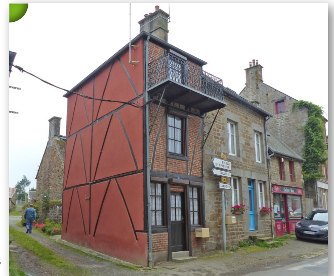
Façade en brique et pans de bois, balcon en fer à la Carneille.
