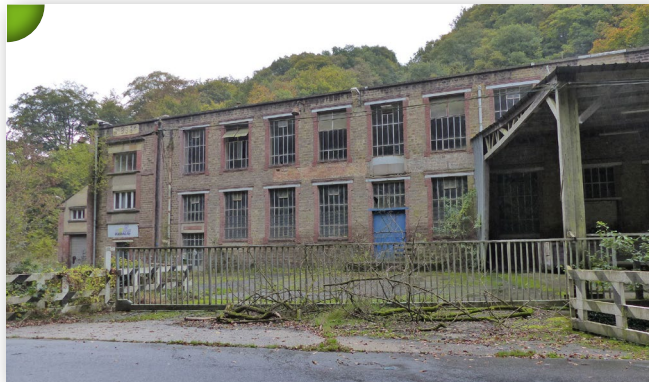
Ancienne usine de filature de coton en brique, à l'abandon dans la vallée de la Vère, vers Athis-de-l'Orne.
