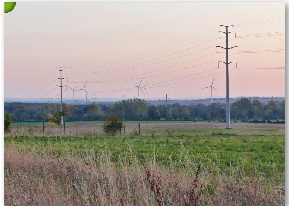
Couloir bocager, éoliennes et lignes à haute tension.
