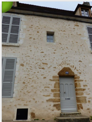
Maison de ville à Mortagne-au-Perche : le sable clair de l'enduit est rehaussé par la pierre ocre d'appareillage et d'encadrements.
