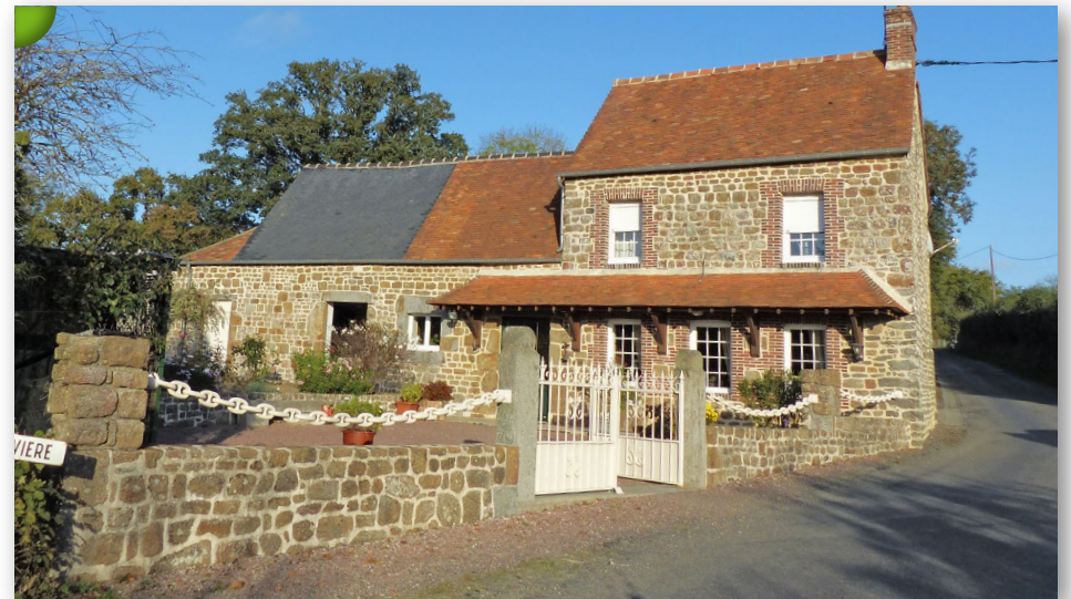
Ferme avec façade en moellons de granit roux et encadrement en briques sous tuiles plates. Lougé-sur-Maire.
