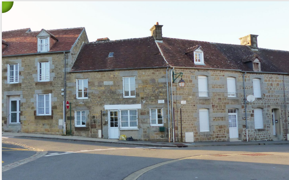
Maisons mitoyennes. Façade sur rue en pierres et moellons de granit roux à clair avec encadrements de pierres de taille en granit bleu, sous tuiles plates. Centre-bourg de Rânes.
