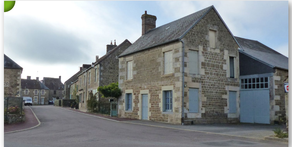
Façade sur rue en moellons de granit roux à clair avec encadrements et chaînes d'angles en pierres de taille de calcaire, sous ardoises. Centre-bourg de Vieux-Pont.
