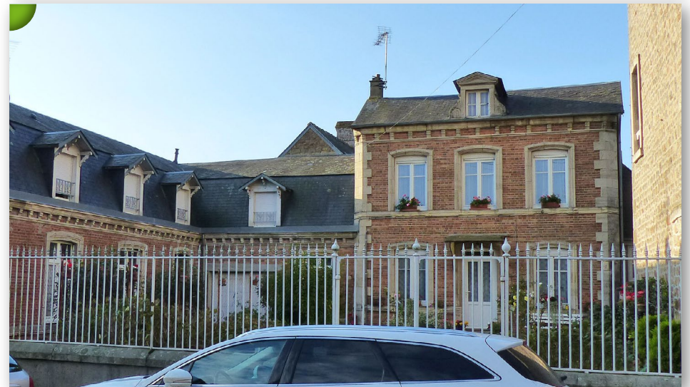
Usage de la brique mélangée au granit à la Ferté Macé. Façades en briques : encadrements, bandes et chaînes d'angle en granit clair, sous ardoises.
