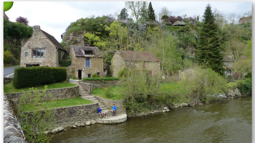
Vue depuis le pont sur les jardins en terrasse (parfois enclos de murs) très caractéristiques du site. Saint-Céneri-le-Gérei.
