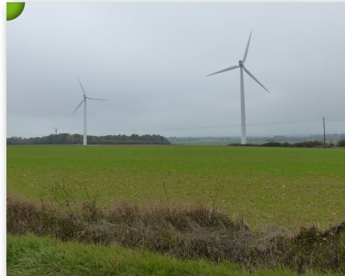
Éoliennes implantées le long de la route départementale n°8 à l'Est d'Alençon.
