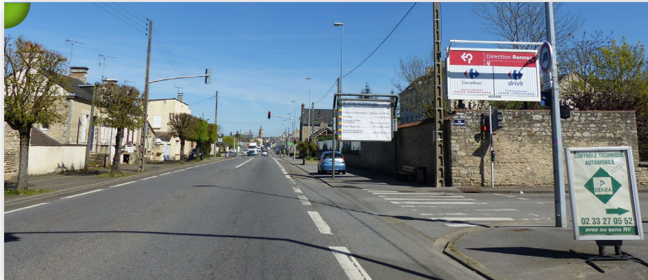
RD 338 - Voie rectiligne à l'entrée sud d'Alençon. Le traitement routier peu qualitatif de cet espace crée une rupture nette et large dans la ville et pas du tout propice à la promenade.
