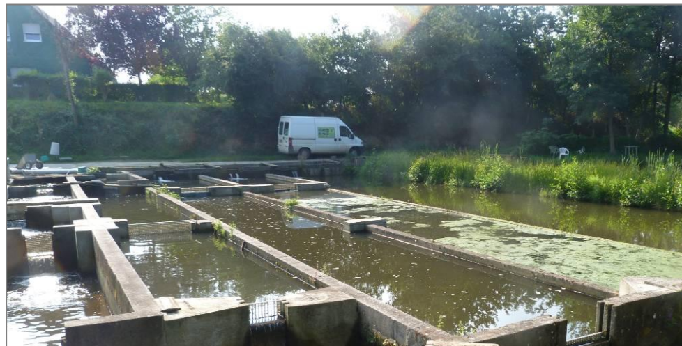
Pisciculture de Joué-du-Plain, en cours de rénovation (2013)
