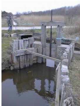
Photo 3 : porte à flots du marais de Ver-sur-Mer
