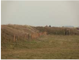
Photo 8 : clôture de canalisation en arrière du cordon dunaire
