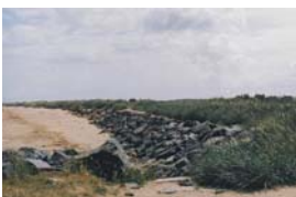
Photo 2 : enrochement à Meuvaines
