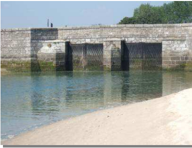
Portes à flots du pont de Saire
