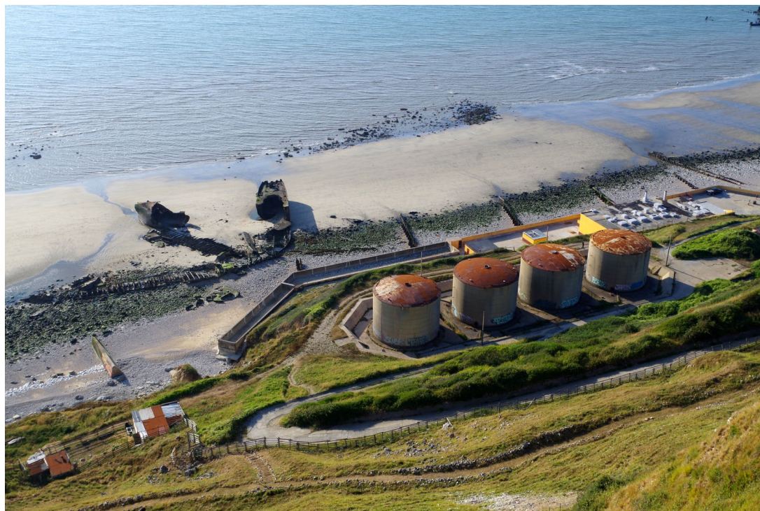
Figure 22 : Station de pompage de l'OTAN - A. PERIER / OFB
