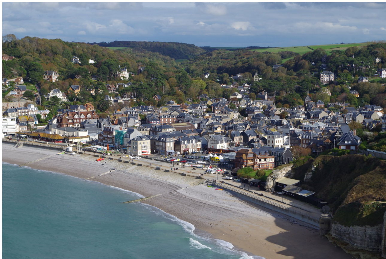
Figure 60 : Etretat s'est développée à proximité immédiate de la mer, développant inévitablement des ouvrages de protection comme les perrés et les digues - A. PERIER / OFB
