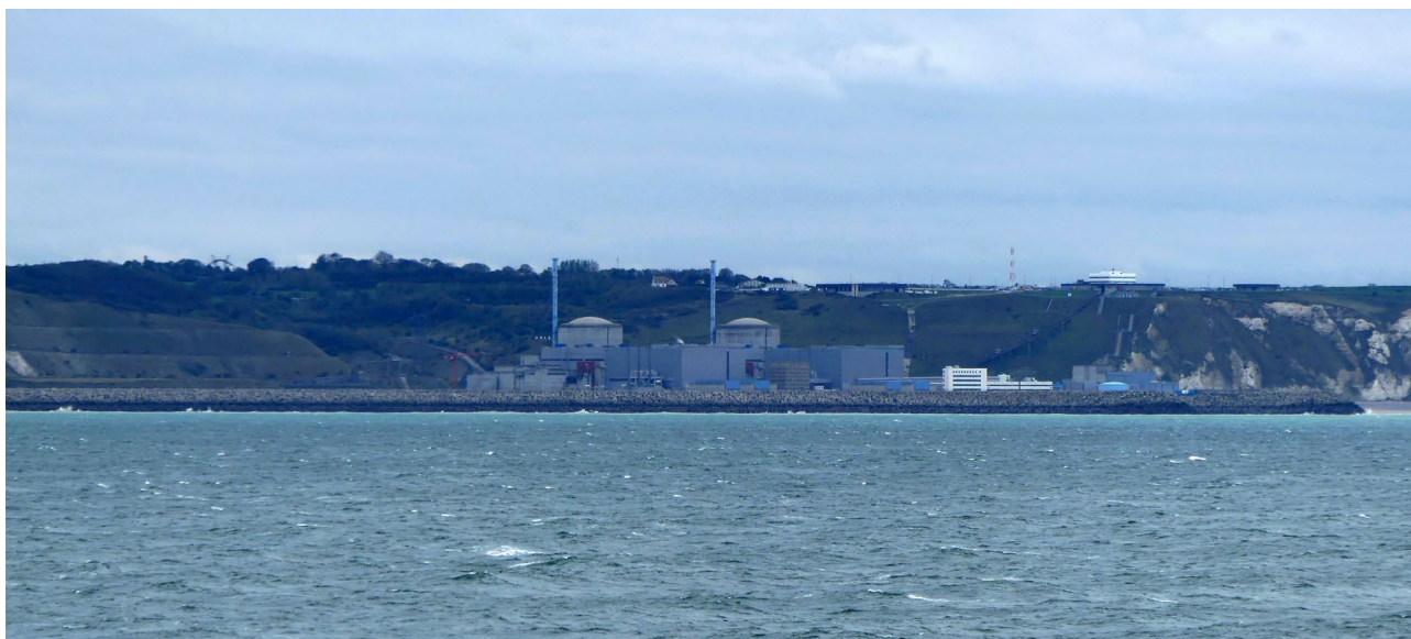
Figure 28 : Vue de la centrale nucléaire de Penly - S. PONCET / OFB
