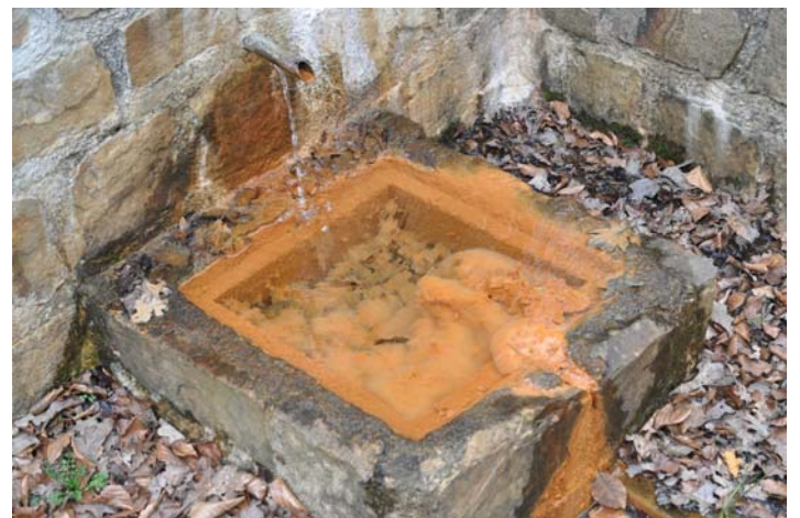
Site 2 : Enduit ferrugineux dans la vasque de la « fontaine minérale » (© F. et P. Gigot)
