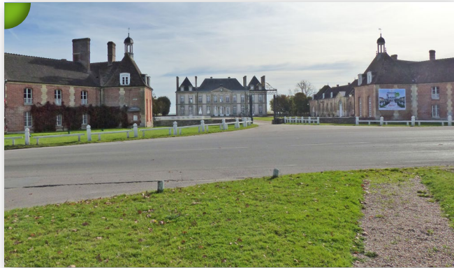
Haras du Pin. Écuries et communs : bâtiments bas dominés par la brique sous tuiles plates, tandis que le château est constitué en pierres de taille claires sous ardoises.
