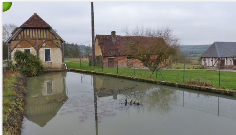
Corps de ferme ancien composé de quatre bâtiments à pans de bois et briques ; sur la RD 703 vers les Fontenelles.
