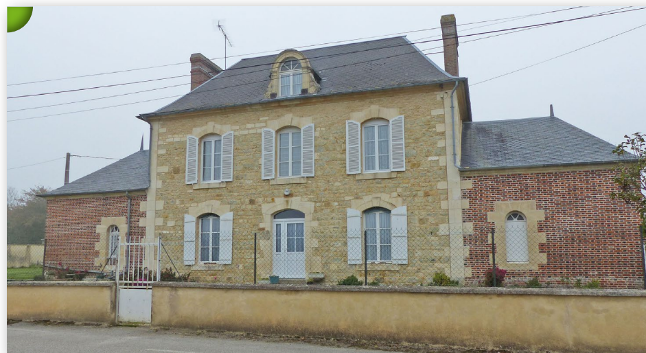
Bâtisse en moellons de calcaire avec encadrements et chaînages d'angles en pierres de taille. Ailes de la bâtisse en briques avec encadrements en granit sous ardoises. Sur la RD 26 vers Survie.
