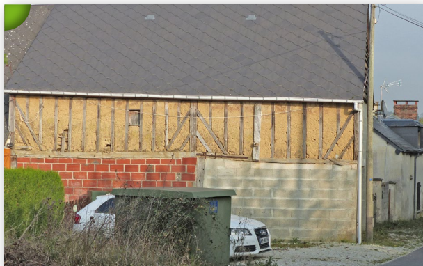
Bâtiment en pans de bois et briques ayant été successivement et de façon peu équilibrée, transformé avec des parpaings ; vers Saint-Evrault-de-Montfort sur la RD 721.
