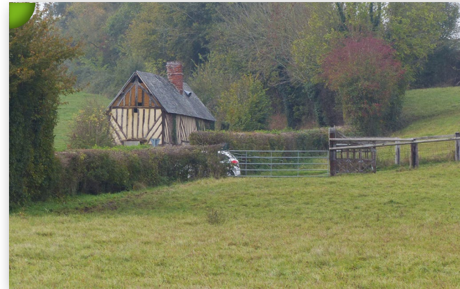
Ferme à pans de bois sous ardoises, isolée au sein d'un maillage de haies basses et implantée perpendiculairement à la pente, vers Guerquesalles.
