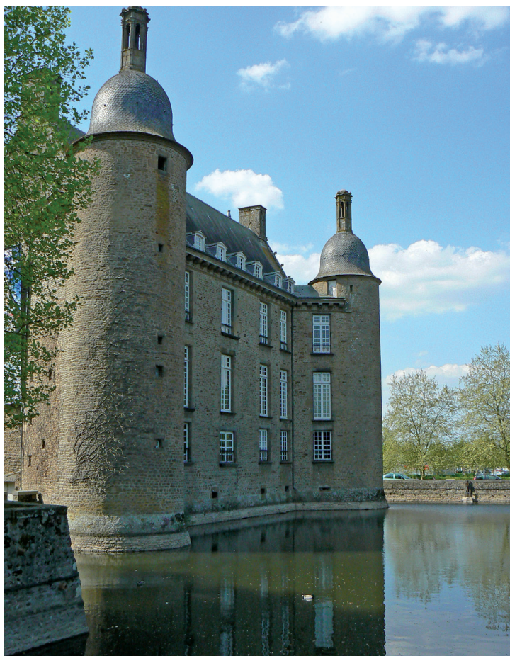
Le château et ses doves
