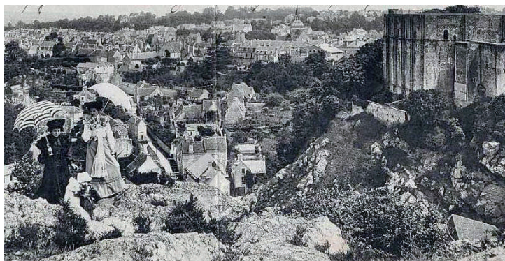
Vue générale sur Falaise prise du Mont Myrrha
