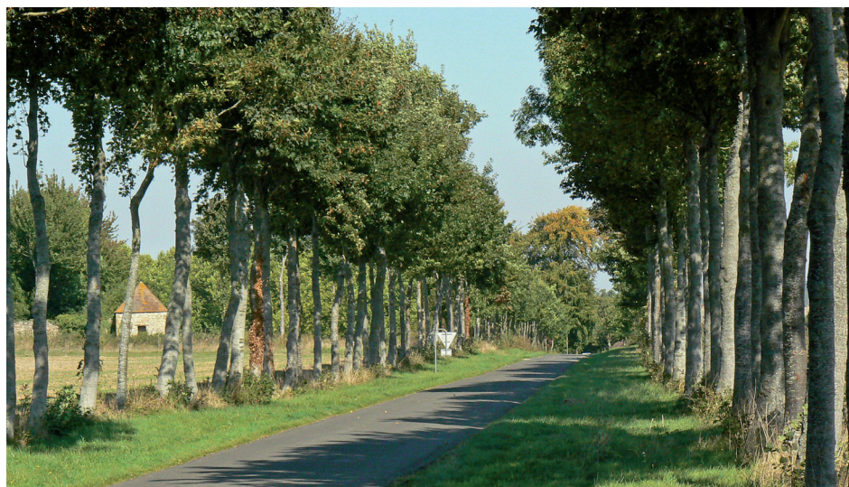
Le CD 157 près de l'entrée du château
