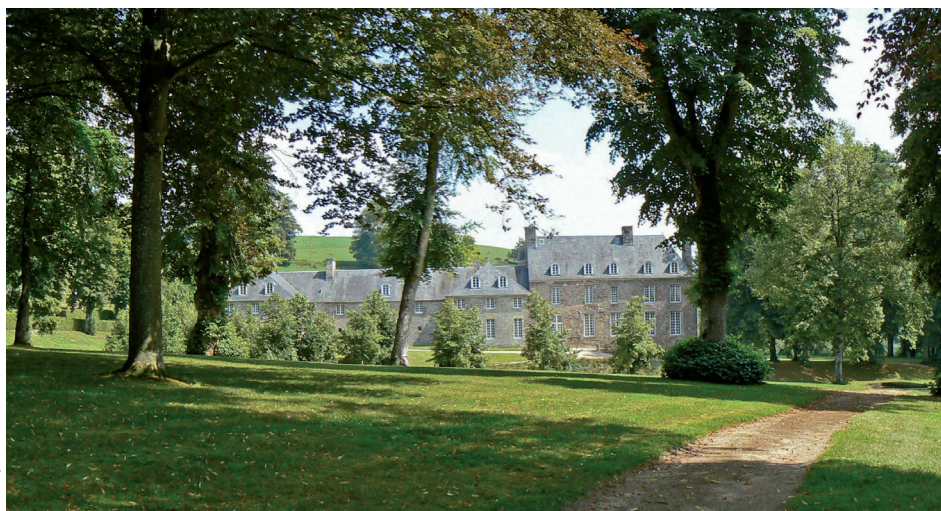
La façade nord-ouest du château vue du parc
