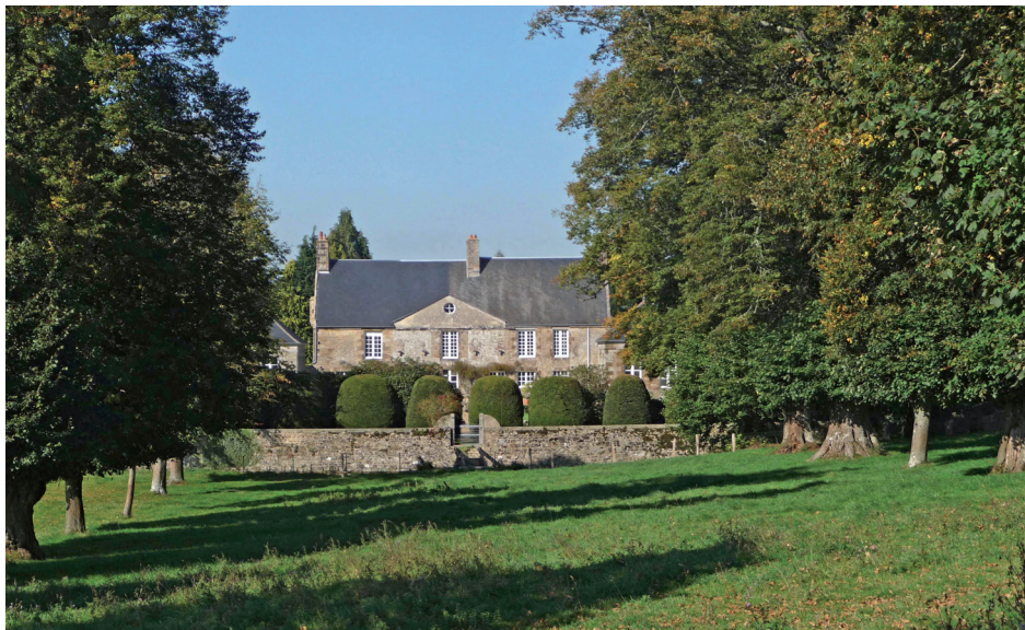
Le corps de logis principal et l'ancienne allée d'entrée
