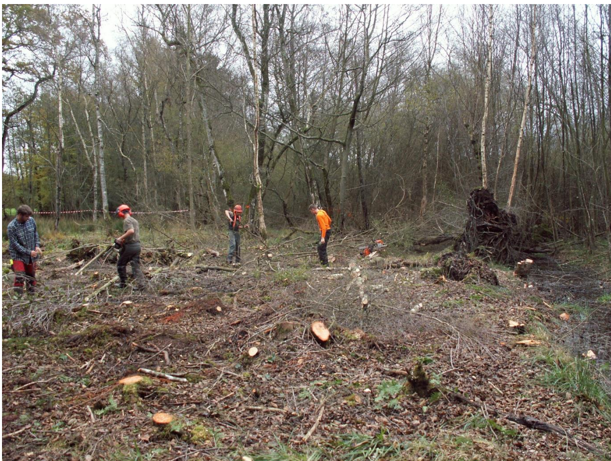
Figure 55 : Chantier mené par des élèves de la MFR des Forges, sur le site, à Bresollettes
