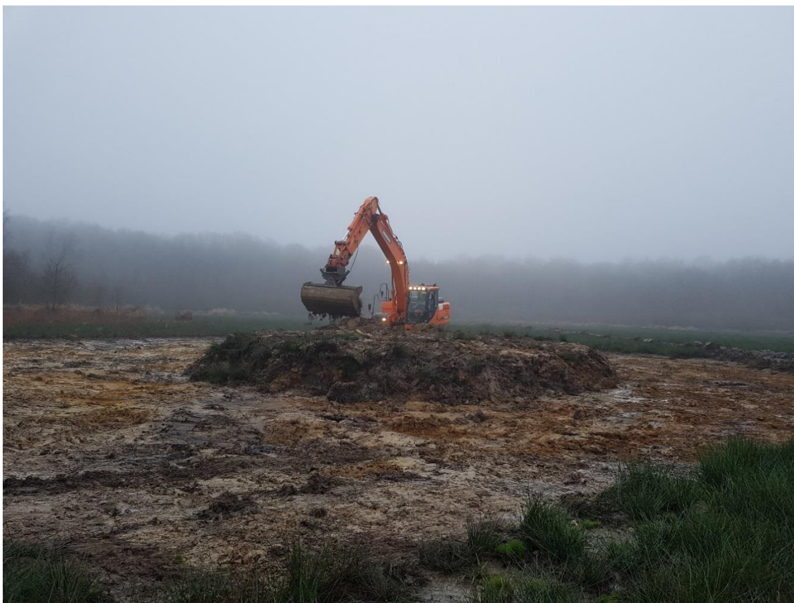
Figure 43 : Création d'un îlot sur l'étang du Belloy, Marchainville
