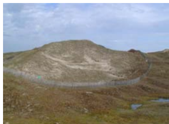
Caudeyre en cours de restauration - (Lindbergh)
