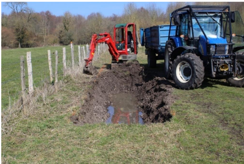
Photo 12 : Création d'un fossé sur la parcelle CASE
