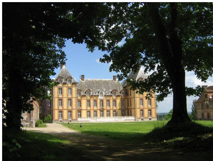
Photographie 1 : Château de Brémontier-Merval
